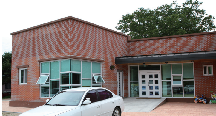
▲ 전능자의그늘미니스트리 건물 전경. © 복음기도신문
